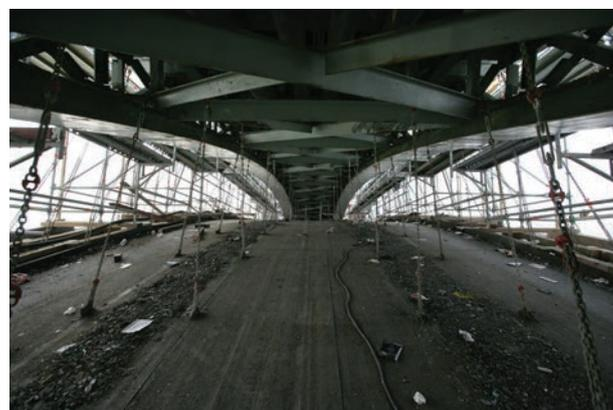
Fig. 3- Nuovo impalcato sotto il Ponte realizzato per la sicurezza in fase di cantiere e razionalizzare le operazioni di restauro, sia dell'acciaio, sia del legno. Su questa elegante ed essenziale sostruzione appoggiano anche le "ali" pedonali
