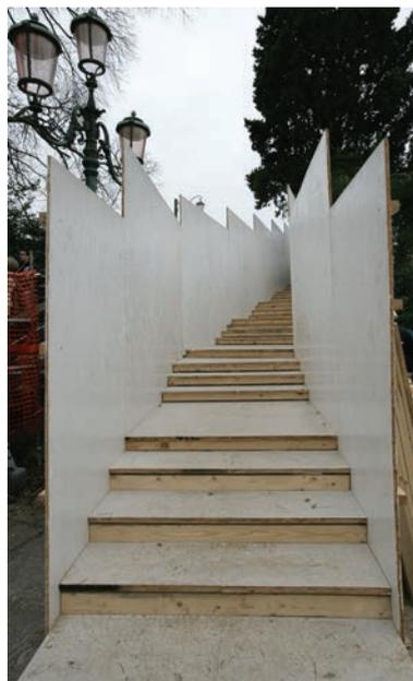
Fig. 4- Passerella esterna al ponte affinché i pedoni non intralciassero i lavori sul ponte
