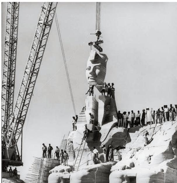
Fig. 9 - La ricollocazione del volto di Ramses sulla facciata ricostruita 60 metri più in alto e 280 metri più indietro
