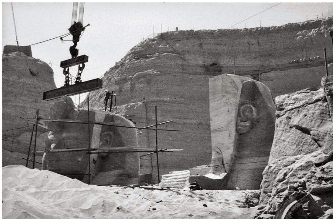
**Fig.8 - Il blocco della testa di Ramses dopo il taglio del volto che fu rispettosamente mantenuto intatto**
