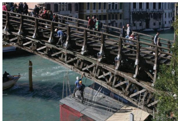
Fig. 1- Inizio della realizzazione della sottostruttura del Ponte per appoggiare le "ali" e il piano di lavoro e cantiere
