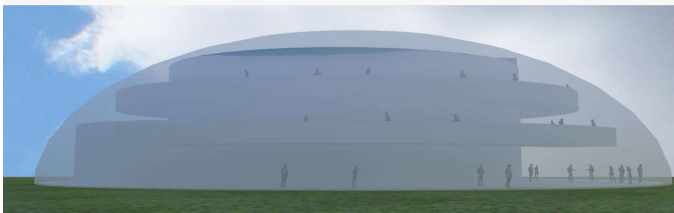
Fig. 5- Particolare del volume vetrato contenente la sala da concerto con i foyer anulari su tre livelli
