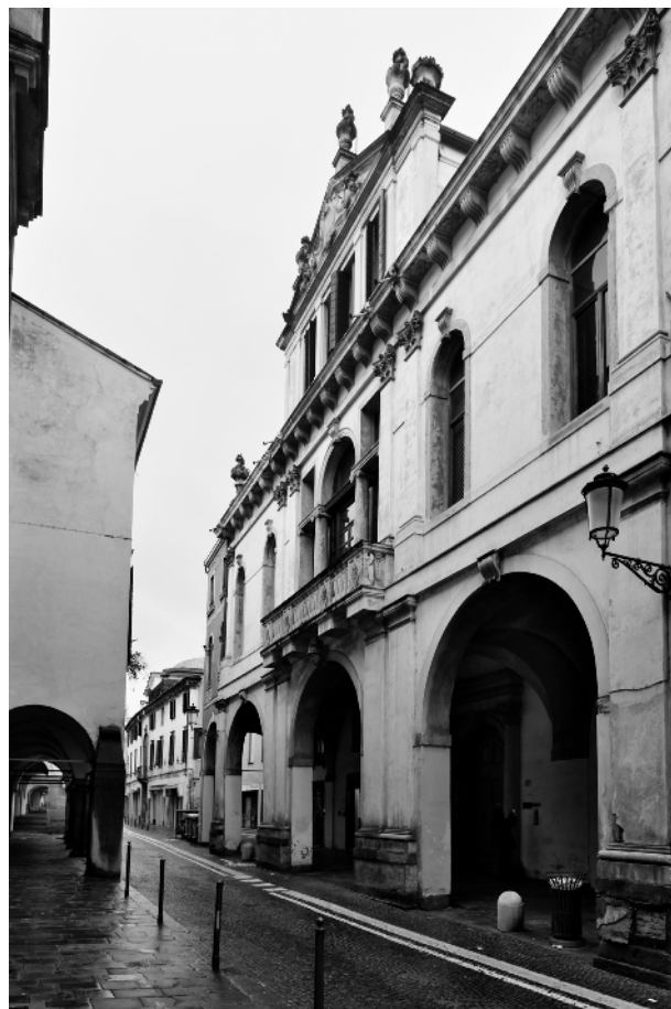
Fig. 26 - Palazzo Cappello (oggi Dolfin-Compostella)
