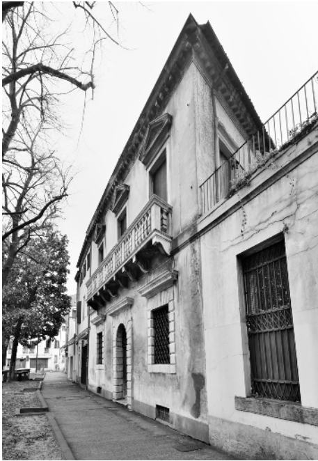
Fig. 32 - Palazzo Cornaro-Priuli-Pesaro, particolare della rotazione muraria dello spigolo dell'ala est
