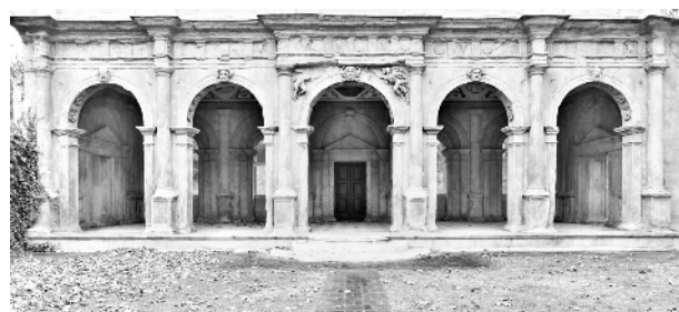
Fig. 11 - Loggia Cornaro, il pianterreno
