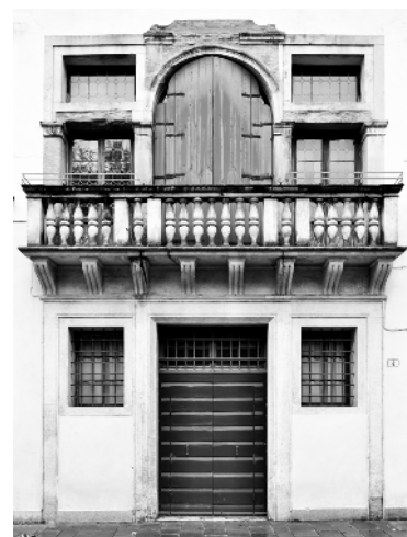
Fig. 25 - Palazzo Mocenigo, la serliana in facciata dell’ala sud
