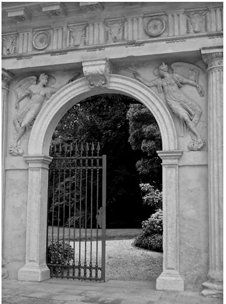
Fig. 21 - Palazzo Mantova Benavides, particolare dell’arco di trionfo
