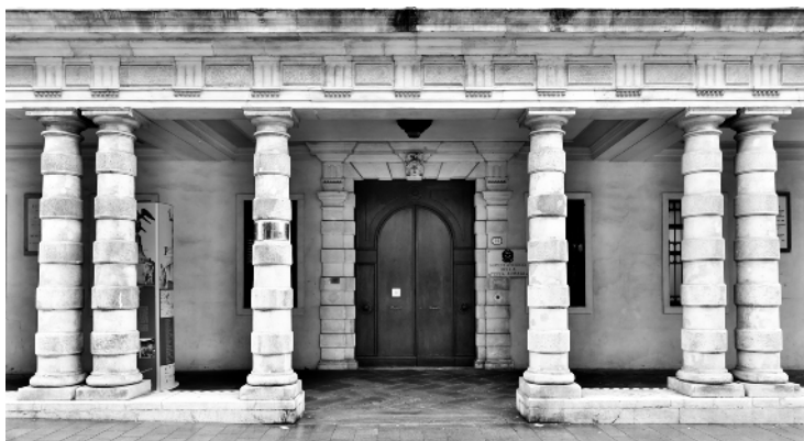
Fig. 18 - Palazzo Bembo, particolare del portico
