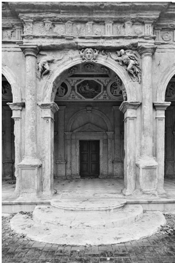
Fig. 12 - Loggia Cornaro, particolare dell'arco centrale
